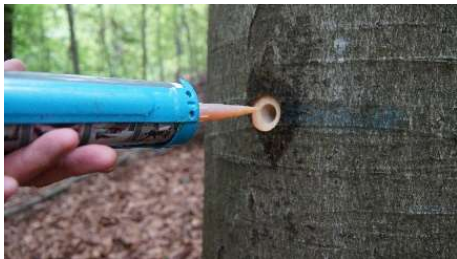
2.3.5 Harz einbringen dabei ca. 1/3 des Bohrlochs füllen.
