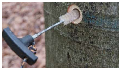
2.3.3 Bohrloch ausbürsten.
