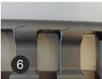
6 Vérification que les ancrages IMN&CLiC-iT LDV n'ont pas subi de déformations dues à des chocs, des déformations dues à de la surcharge dans les emplacements des vis ou dans le trou où passe le câble de sécurité
