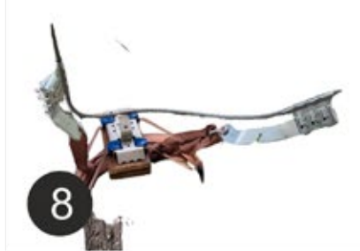
8 Vérification de la corrosion sur tous les éléments IMN&CLiC-iT LDV installés (ancrages, bras, anti-retours, etc...)
