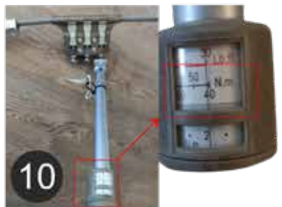
10 Vérification du serrage des vis M10 dans les ancrages LDV (=40N*m)
