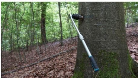
2.3.7 Bolzen mit Teleskopratsche ggf. bis in die Endposition eindrehen.
